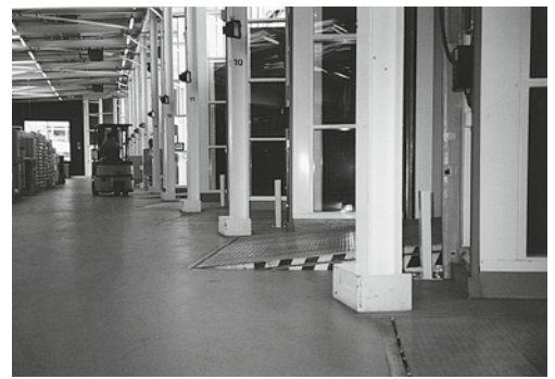
4 Angehobene Rampen stellen eine Stolpergefahr dar. Die seitliche Markierung macht auf diese Gefahr aufmerksam.
