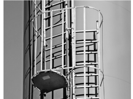
10 Umsteigebühne an zusammengesetzten Leiterzügen. Das Podest der oberen Leiter muss min. 70cm breit sein und die Korbfläche ausfüllen.
